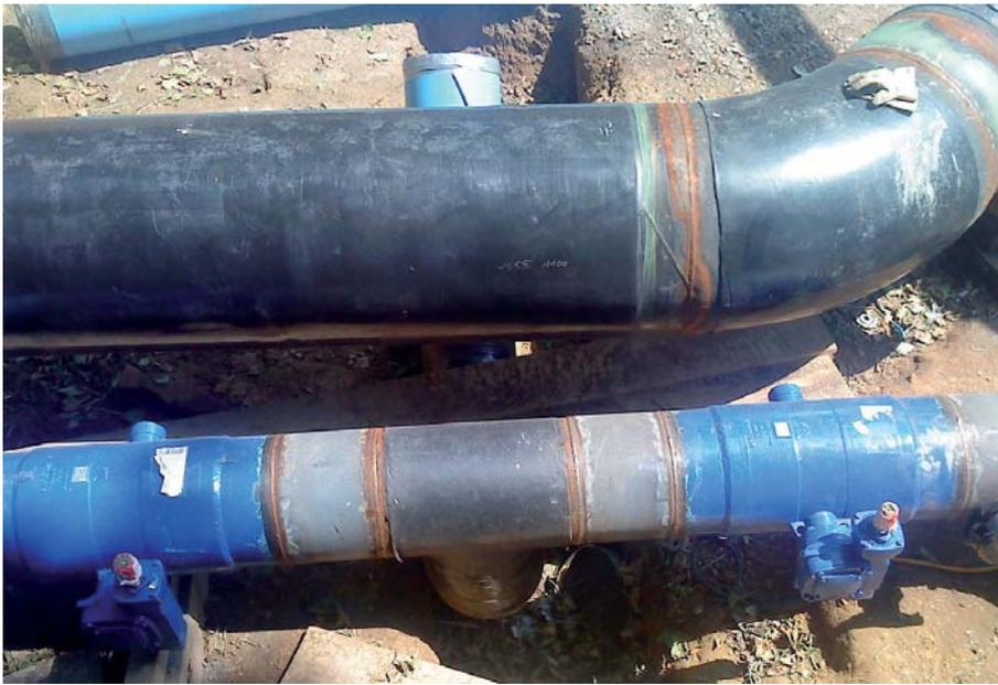
**Bild 3:** Hydromaten mit Anschweißenden in Wasserleitung aus Stahl
